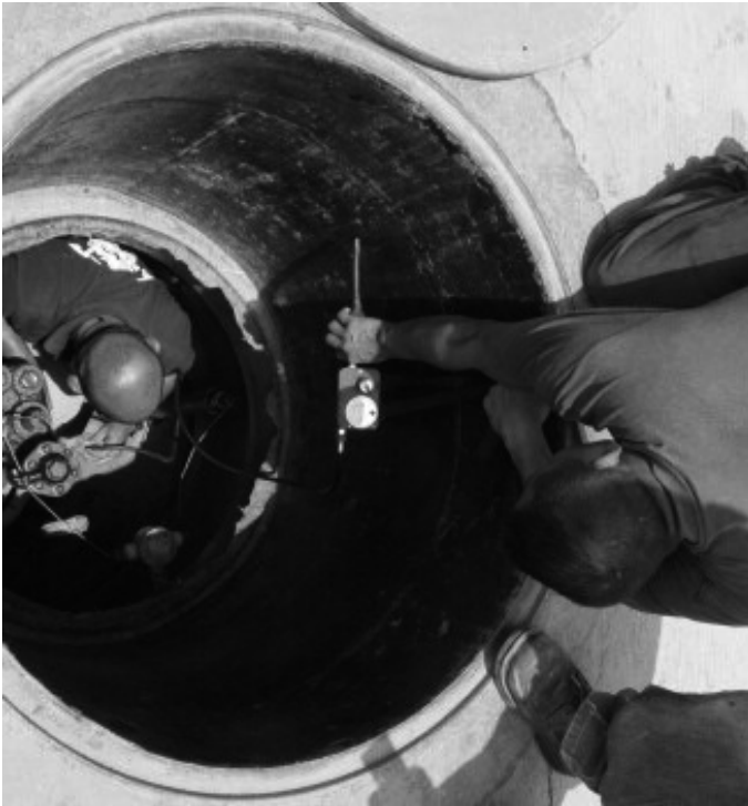
Comprobación ATEX en un pozo de gasolinera.
